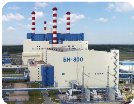
Белоярская, Нововоронежская, Калининская, Ленинградская АЭС Система вибродиагностики турбины
