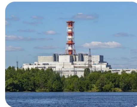
Смоленская АЭС Установка ионоселективной очистки комплекса переработки ЖРО
