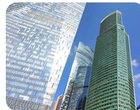
Башня Евразия, Москва-сити Разработка и внедрение АСДУ инженерных систем башни Евразия
